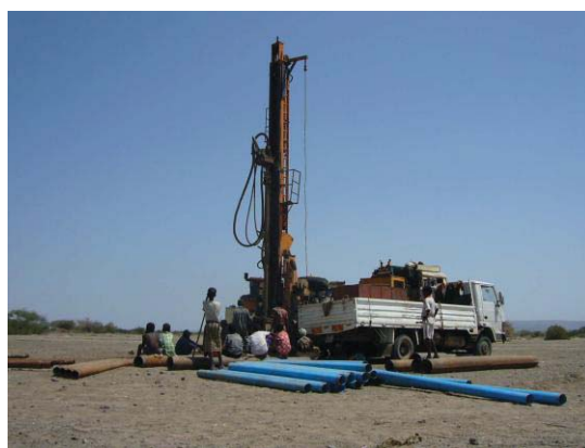
Figura 3. Máquina de rotación y tuberías piezométricas empleadas en la ejecución de los pozos en Mille en Septiembre 2009.
