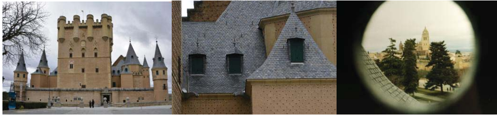
Figura 1. Alcázar de Segovia. Detalle de las ventanas de los Desvanes. Orificio de ventilación de las ventanas desde el interior de los desvanes.
