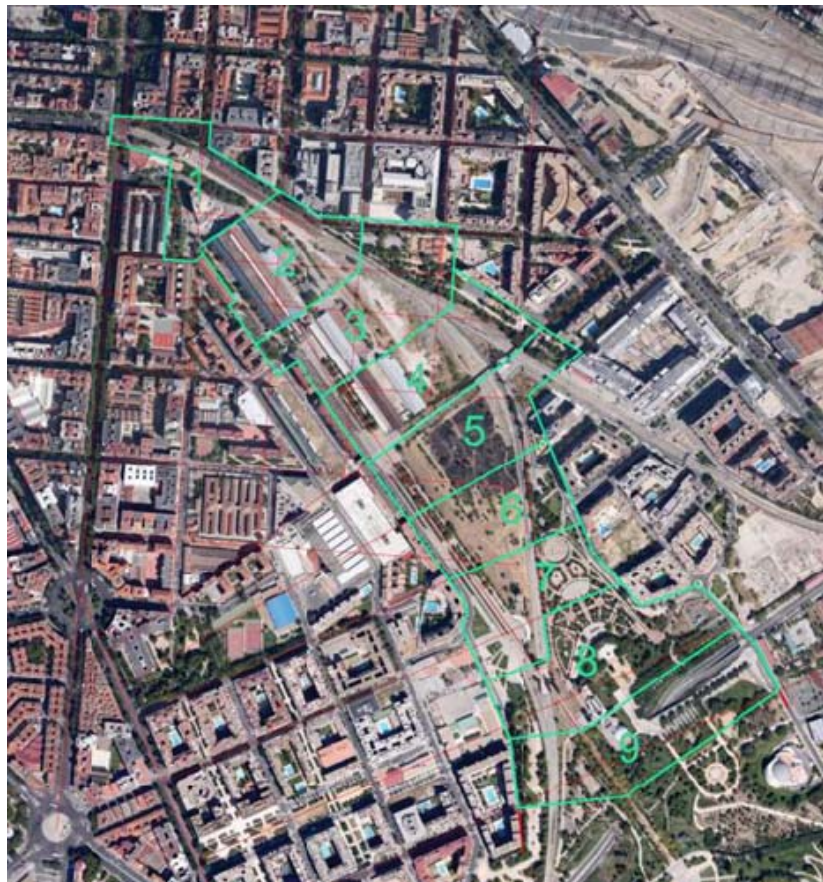
Figura 2. El área de trabajo subdividida en nueve bandas desde la “cabeza” hasta la “cola” con aproximadamente 125 metros de anchura cada una.
