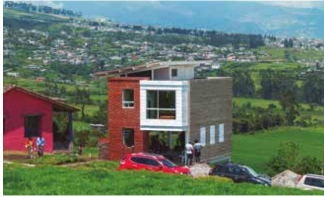
Figura 7 La casa modelo se edificó junto a la casa comunal. Fuente: Fotografía de Carmen Elena Ribadeneira.
